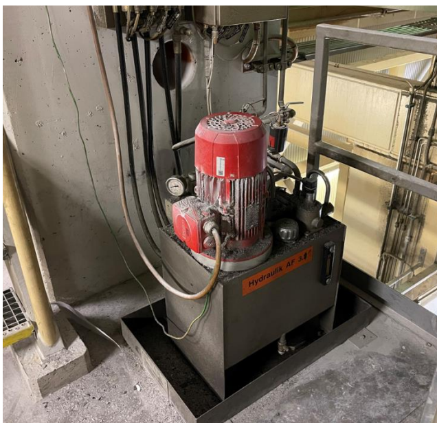
Figura 14: Sistema hidráulico do sistema aerofólio
